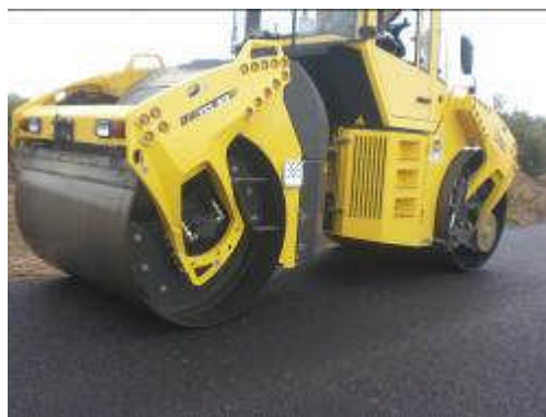
Foto 13. Compactación de MBTE
