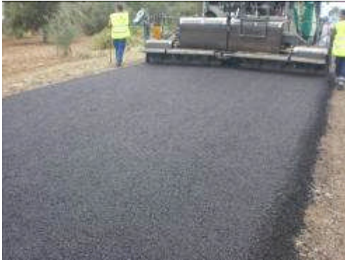
Foto 10. Extendido mezcla templada cerrada
