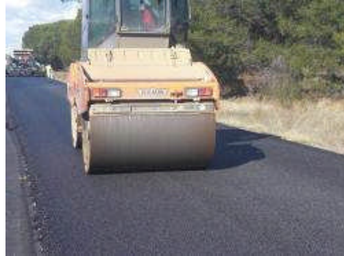
Foto 10. Compactado mezcla templada
