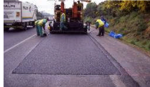
Foto 9. Extendido mezcla templada abierta en bacheo
