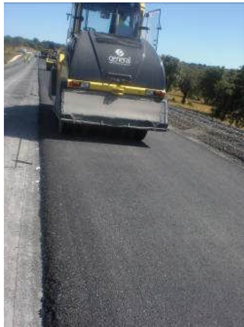
Foto 9. Extendido mezcla templada cerrada en intermedia
