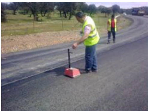
Fotos 14 y 15 Control de la compactación del tramo de prueba con gamma densímetros y probetas testigo
