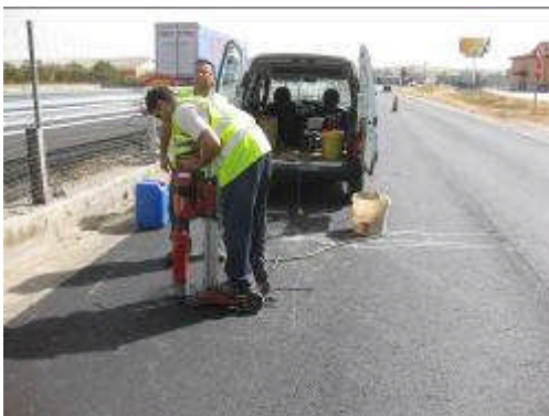
Figura 17 Mezcla templada reciclada a tasa total. Toma de testigos (24 horas después de extendido)
