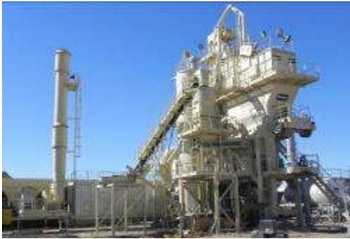
Fig 8.- Planta discontinua con el sistema de adición de MRMB
