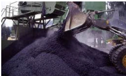
Foto 4. Acopio en planta
